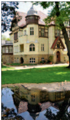
■ Die „Villa Medon“ liegt in einer parkähnlichen Außenanlage mit hochgewachsenen Bäumen und einem kleinen Naturteich.
